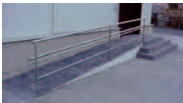
Amorebieta. Rampa de acceso exterior al edificio.
