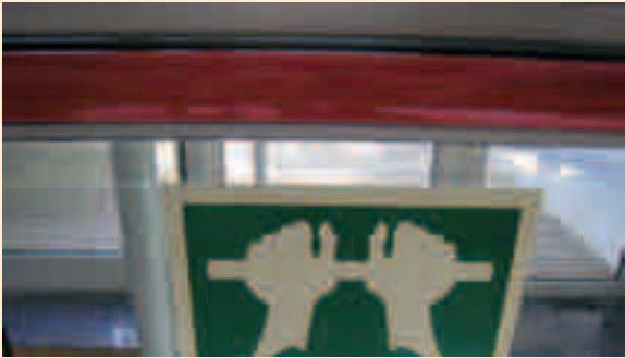
Zorrotza. Marcaje puerta evacuación con dispositivo antipático.
