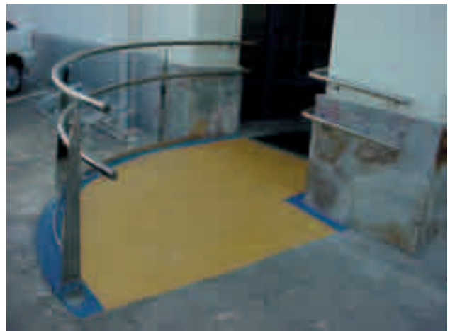
Plazakola. Rampa de entrada al taller.
