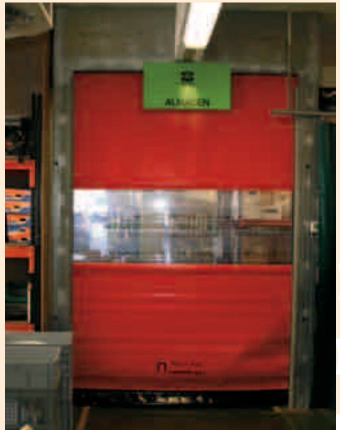
Rekalde. Puerta seccionadora de accionamiento rápido para mejorar el confort térmico.
