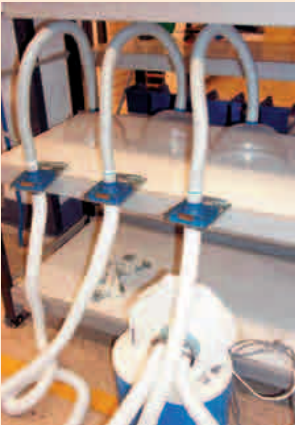
Sestao. Aspiraciones focalizadas para trabajos de soldadura en electrónica.
