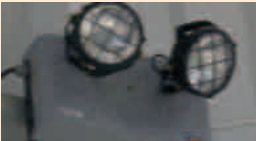
Zalla: Batería de luces de alta potencia.
