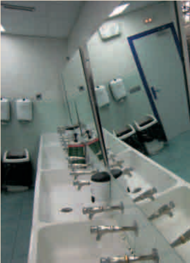
Amorebieta. Batería de pilas de lavamanos en vestuarios. Espejos con desplome para poder permitir su visión a los usuarios en silla de ruedas o personas de talla baja.
