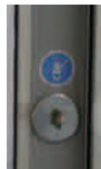
Zorrotza: Punto de anclaje de seguridad para trabajos de limpieza de cristales.
