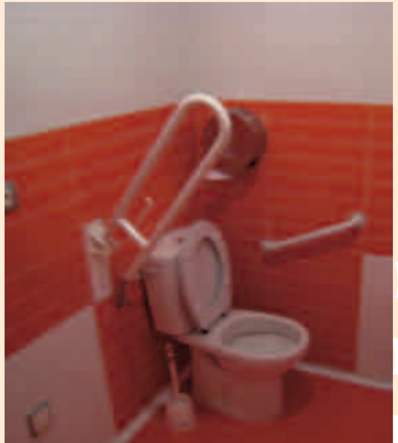
Rekalde. Baño adaptado con barandillas y pulsador de emergencia.
