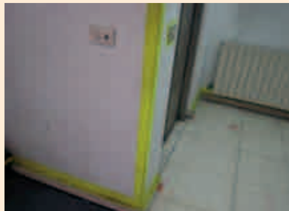
Erandio. Resalte cromático de zócalos y esquinas.
