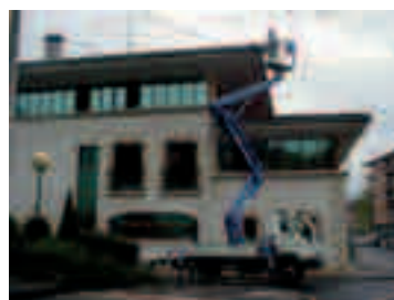
Servicios medioambientales: Brigada de cristaleros. Uso de plataforma aérea.
