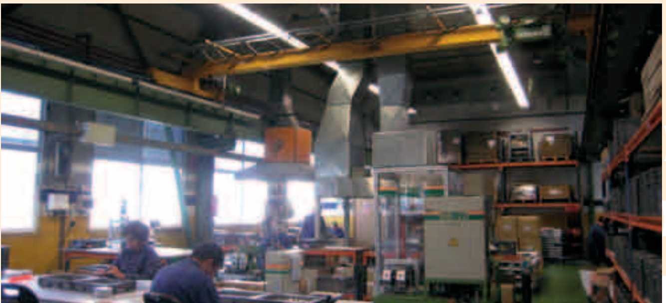
Etxebarri. Líneas de luminarias e iluminación natural taller.
