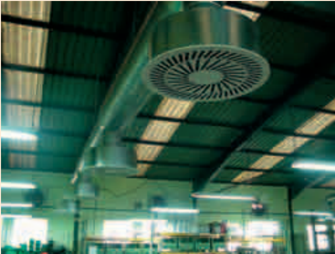
Txibila. Instalación de aire acondicionado.
