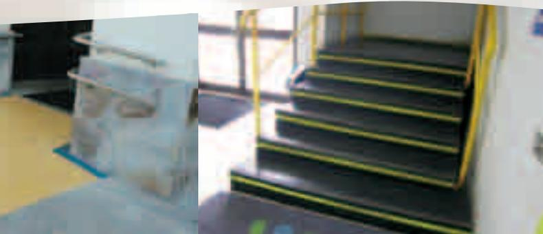
Los pasillos y suelos deberían estar libres de cambios de nivel, resaltes, huecos etc. En el caso de que fuera preciso, se salvarán los desniveles mediante rampas progresivas con pendientes menores de 8%. Pendientes superiores suponen un sobreesfuerzo infranqueable para ciertos usuarios, dificultan la asistencia de los auxiliares, etc.
